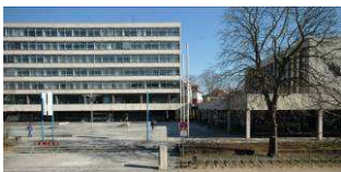
Braunschweig, Hochschulforum der Technischen Universität (Architekt: Friedrich Wilhelm Kraemer), der Sanierungsprozess schreitet voran.
