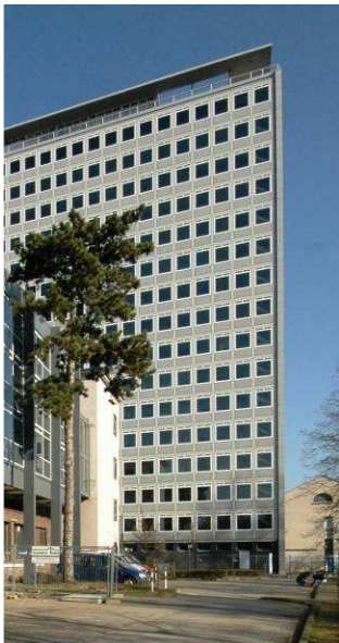
Braunschweig, „Okerscheibe“ der Technischen Universität (Architekt: Dieter Oesterlen) nach der Sanierung.
