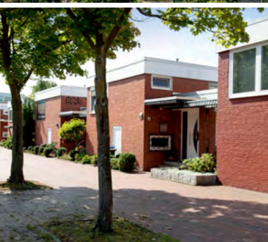
Wolfsburg-Detmerode mit Blick auf die Hochhäuser Don Camillo und Peppone Einfamilienhäuser in der Teppichsiedlung, 2012 Fotos: Lars Landmann
