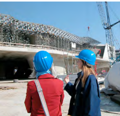
Führung auf der phaeno-Baustelle in Wolfsburg, 2004.
