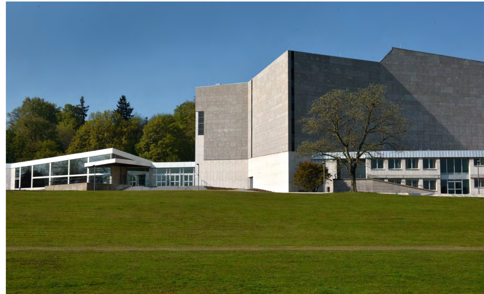
Scharoun-Theater, Wolfsburg. Die Generalsanierung des 1973 eröffneten Theaters von Hans Scharoun in Wolfsburg verband 2014/15 neue technische Anforderungen mit einer energetischen Verbesserung der Substanz. Basierend auf einer fundierten Analyse der Wärmeverluste wurde z.B. der Energiebedarf des Foyers durch den Austausch der Verglasung, die Dämmung der großflächigen Flachdächer und der Sockelzone um 40% reduziert. Das mit großer Anstrengungsbereitschaft verfolgte Ziel des geringstmöglichen Eingriffs in die Substanz lässt sich auf nicht geschützte Bauten übertragen. (Fotos: Lars Landmann)
