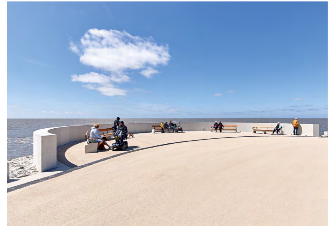
Auf der Naturparkpromenade in Norden als Teil eines barrierefreien Rundwegs können sich Einwohner und Besucher treffen, sich vom Spaziergang ausruhen und miteinander reden. WES LandschaftsArchitektur GmbH, Hamburg. (Foto: Guido Erbring)
