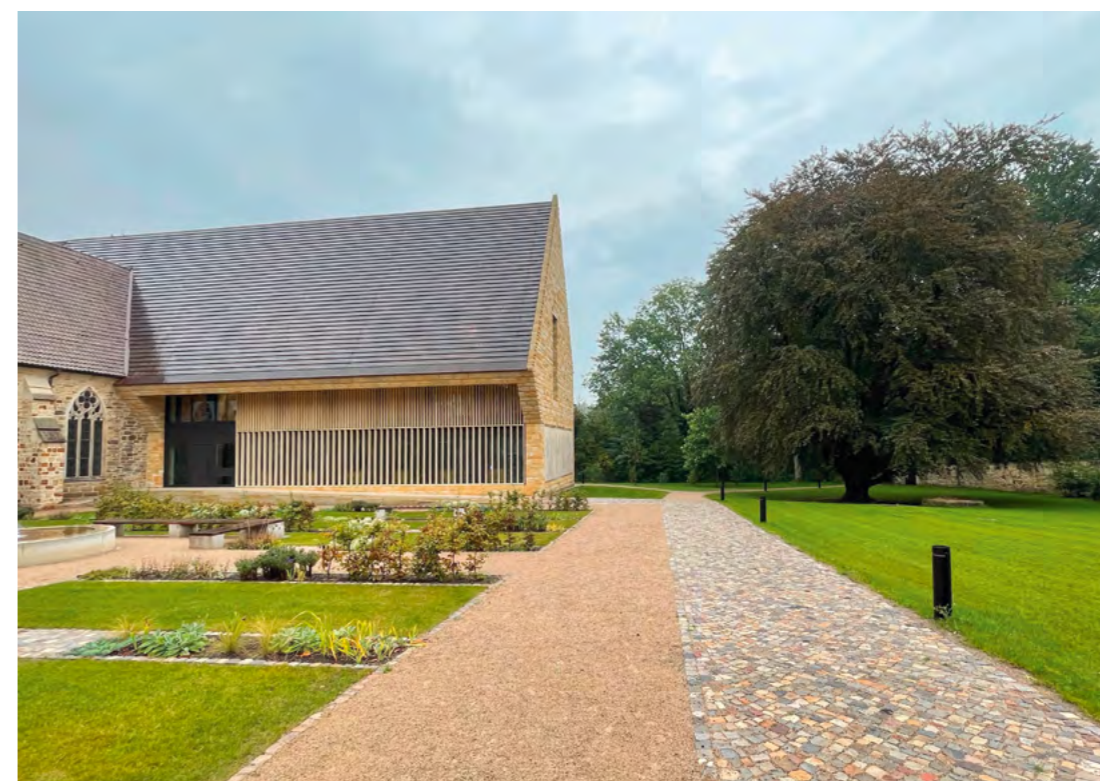
2021 wurde der hinzugefügte Neubau fertiggestellt. Er beherbergt eine Bibliothek und ein Unterkunftsgebäude des Predigerseminars (Entwurf Neubau: pape+pape architekten), es wurde mit dem Deutschen Natursteinpreis 2022 ausgezeichnet. Alt und Neu gehen eine harmonische Symbiose ein - mit Neubauten dort, wo bereits früher Bauten standen. Das Kloster beherbergt einen für die Öffentlichkeit zugänglichen Bildungscampus. Auf diese Weise ist ein Ort mit Zukunft und neuer Funktionalität entstanden, der die Öffentlichkeit einbezieht und den Klimaschutzgedanken nicht ausblendet. (Foto Johanna Sievers)
