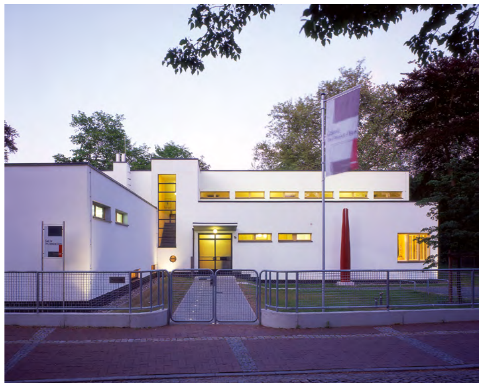
Neues Bauen mitten in der historischen Kleinstadt, gestaltet von einer Bauhaus-Architektin. Direktorenwohnhaus in Celle, ab 1930: Katt Both im Büro von Otto Haesler, Sanierung von Simon & Simon (Foto: Jürgen Voss)
