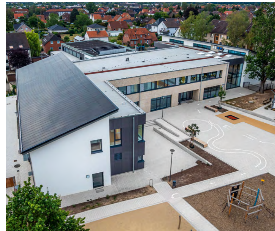
Gebäudeintegrierte Photovoltaikanlage auf den Pultdächern der Grundschule Peine-Stederdorf. Planung: www.passivhaus.de (Foto: Marvin Rust, rustmediasolutions)
