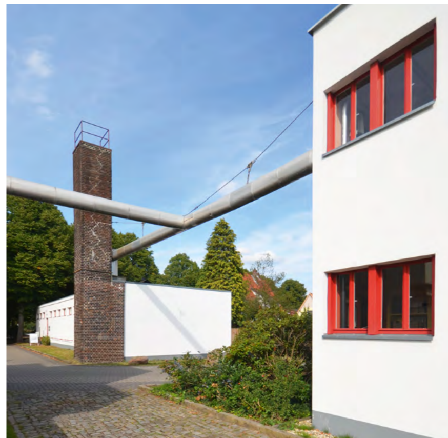
Siedlung Blumläger Feld, Celle. Die Siedlung wurde 1930/31 als seinerzeit wegweisende Wohnanlage mit Kleinstwohnungen nach Entwurf von Otto Haesler errichtet. Die durchdachte Planung – von der Tragstruktur über rationale Grundrisse bis zur Energieversorgung durch ein eigenes Heizwerk und eine Schwerkraftheizung – macht die Häuserzeilen bis heute vorbildlich, auch wenn sich die Ansprüche an Wohnfläche und Komfort geändert haben. Bei einer Ertüchtigung 2013 konnte die Versorgungstechnik weiterverwendet werden – ein Nachweis von Dauerhaftigkeit und sparsamem Ressourceneinsatz. (Foto: Ulrich Knufinke, NLD)
