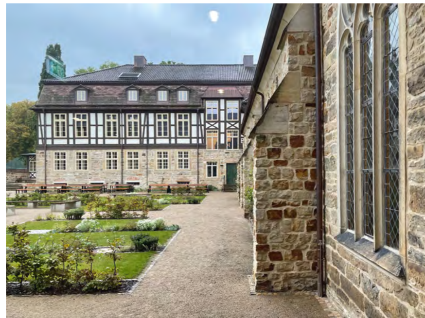
Die Klosteranlage Loccum gehört zu den am besten erhaltenen Zisterzienserköstern nördlich der Alpen. Im Jahr 2000 begann die denkmalgerechte Sanierung des Bestandes inkl. energetischer Sanierung sowie Umstellung auf eine auf Holz basierte Wärmeversorgung. Die denkmalgerechte Sanierung des gesamten Bestandes wurde durch die Architekten Woelk Wilkens und von pax brüning architekten durchgeführt. In dem Zuge wurden auch die Außenanlagen nach einem Entwurf von Wette + Küneke neu gestaltet. (Foto Johanna Sievers)
