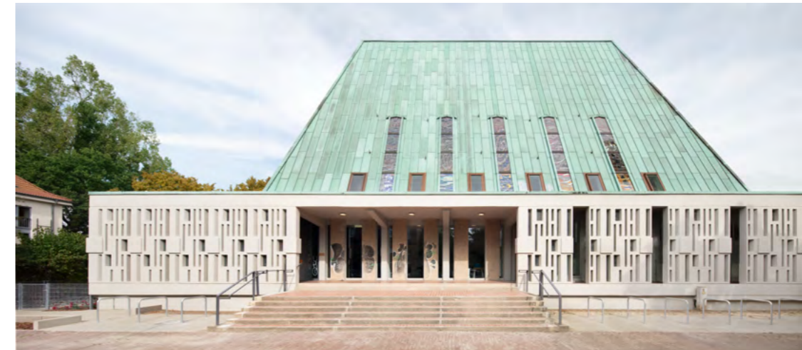
Die Bestandsfassade aus Fertigbetonteilen mit Verbundglasfenstern sowie steil geneigtem Kupferdach wurde mit Schlitzfenstern geöffnet. Das Sichtbarlassen der alten Konstruktion als auch der neuen Eingriffe findet sich überall im Gebäude wieder. Die Neubauvolumen setzen sich mit ihrer Schlichtheit vom 60er-Jahre-Gebäude ab und erhalten den ursprünglichen Raum. Der Zwischenraum des Kirchenschiffs dient als Wetterhülle und Übergangsraum. (Foto: Frank Aussieker)
