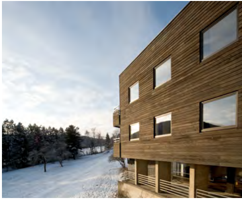
Haus Hessenkopf, Architekt: Karl-Dietrich Lindemann, 1972-75 Foto: Olaf Mahlstedt
