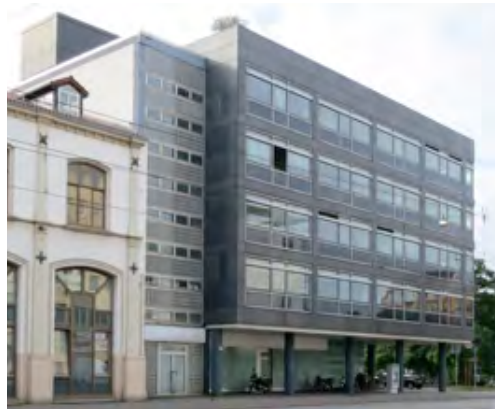
Stadt Hannover, Mitte, Üstra-Hauptverwaltung, Architekt: Dieter Oesterlen 1960, Foto: Rocco Curti / NLD, 2013
