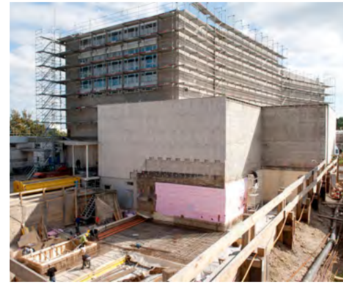
Erweiterungsbau für Sprinkler und Gebäudetechnik, 2014, Foto: Lars Landmann
