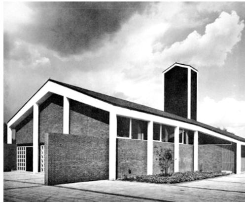
St. Johannes-Kirche, Hannover-Bemerode, Architekten: Ingeborg und Martin Düker, 1962, Foto: Hans Nölter
