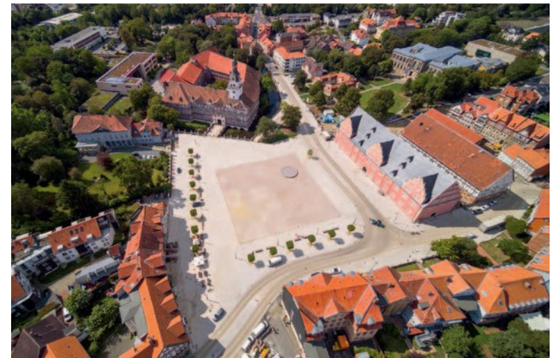
Die Neugestaltung des Schlossplatzes ist das größte Projekt des Zukunftsprofils-Innenstadt Wolfenbüttel gewesen. Die Teilnehmenden wurden zur Einweihung eingeladen und waren stolz, wie nah die Gestaltung des neuen Schlossplatzes an ihren ursprünglichen Ideen und Wünschen liegen. Schlossplatz, ©Henning Kramer
