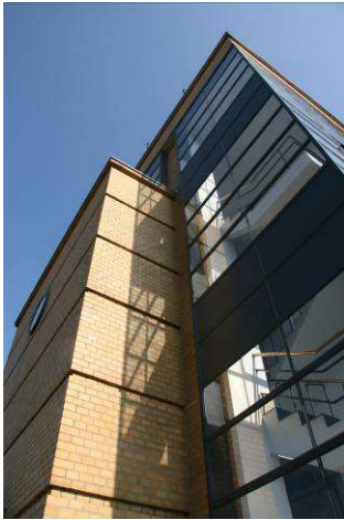
Detail Faguswerk in Alfeld
