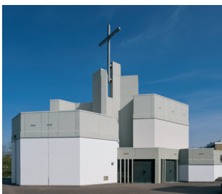
St. Raphael-Kirche in Wolfsburg Detmerode, erbaut 1971-1973 Architekt: Toni Hermanns, Kleve Foto: Olaf Mahlstedt
