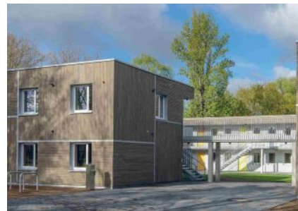
Flüchtlingsunterkunft in Braunschweig Foto: Dohle + Lohse Architekten GmbH
