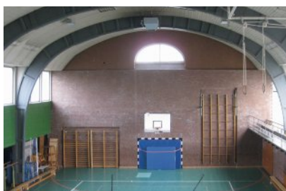
oben und unten: Nordwall-Halle, Celle Fotos: Lothar Haas
