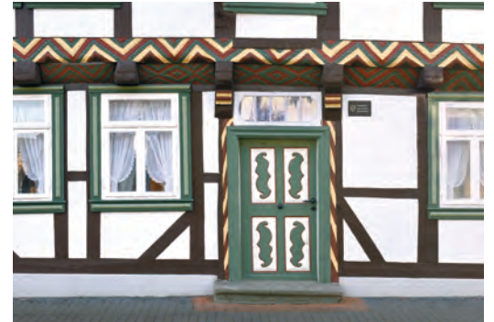
Die Alte Schmiede in Fallersleben, Foto: Lars Landmann
