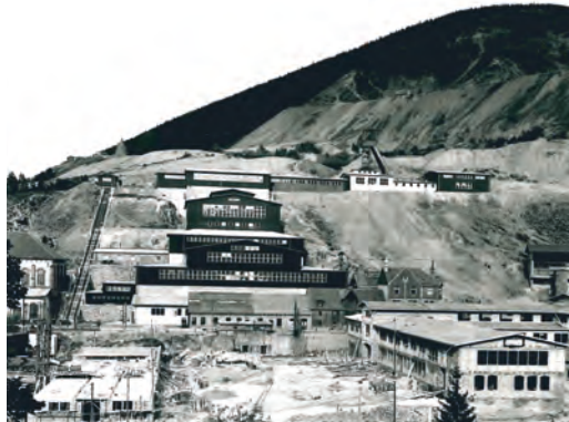
Die Baustelle am Erzbergwerk Rammelsberg 1937. Die Erzaufbereitungsanlage am Berghang ist weitgehend fertiggestellt. Das Magazin- und das Verwaltungsgebäude im Vordergrund befinden sich noch im Bau. Foto: Sammlung Weltkulturerbe Rammelsberg.
