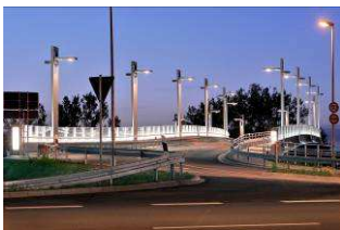
Brücke Sülfeld, 2009 Bünemann & Kollegen Hannover und Gronmij BGS, Tragwerk
