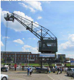
Portalkran von 1927 Fotos: Oswald Lämmel, Stadt Stade – Denkmalschutz
