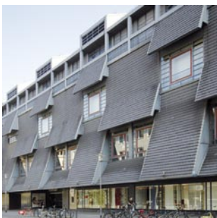
Braunschweig, Karstadt-Kaufhaus am Gewandhaus, Gottfried Böhm, 1978 Foto: U. Knufinke
