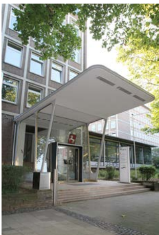
Flugdach im Braunschweiger Stadtbild Foto: S. Bei der Kellen
