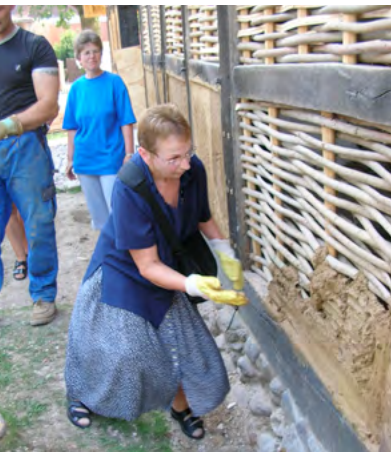
„Bürger mitnehmen“, Aktion einer offenen Baustelle mit Anwohnern, Handwerkern, der Bauleitung und dem Niedersächsischen Landesamt für Denkmalpflege, Foto: NLD
