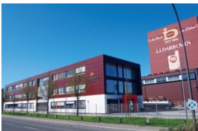
oben: Aufstellen der fertigen Raummodule auf der Baustelle. unten: Neues Verwaltungsgebäude für die Firma Darboven in Hamburg Fotos: ALHO Systembau GmbH
