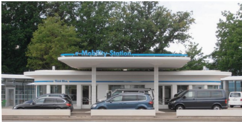
Das ehemalige „Tankwarthaus“ der 1950er Jahre an der Braunschweiger Straße in Wolfsburg, heute e-Mobility-Station
