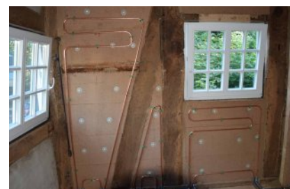
oben: Die Wassermühle nach der Sanierung unten: Wandheizung auf Holzfaserdämmung Fotos: Ralf Jenßen
